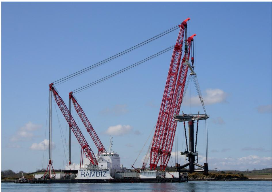
■ Photo 3 : installation de l'hydrolienne Seagen sur le site de Strangford Narrows, Irlande du Nord, par la barge-grue Rambiz. (© Marine Current Turbines, Uk).
